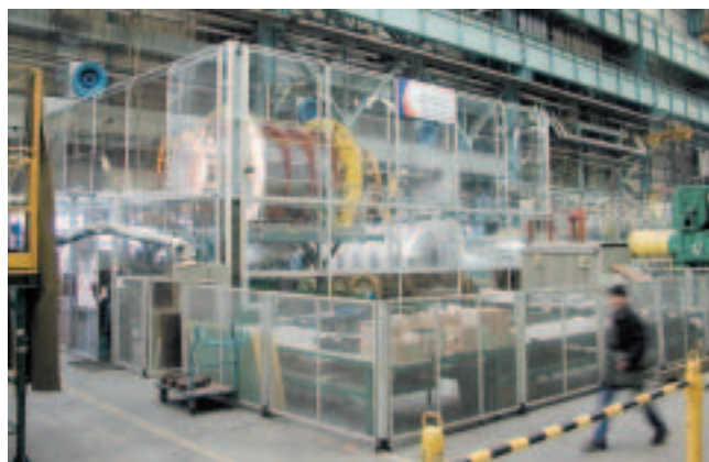
Rys.11. Rdzeń stojana generatora w gorsecie na stanowisku zwojenia
