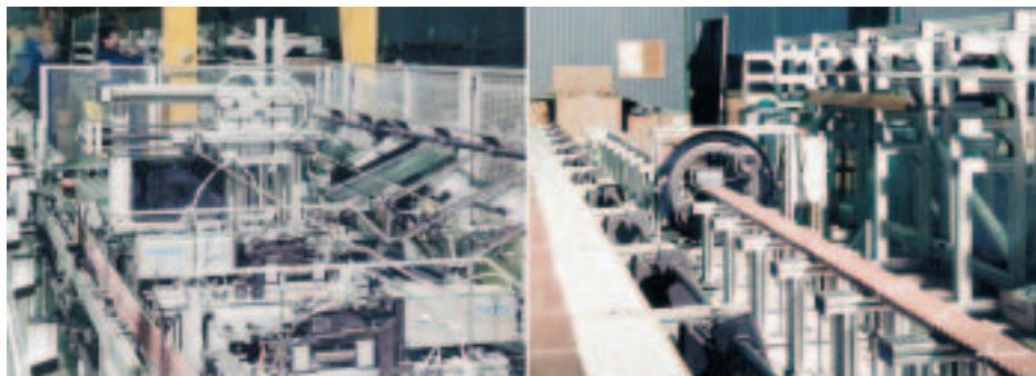
Rys. 9. Stanowisko automatycznego wykonywania pręta uzwojenia stojana
