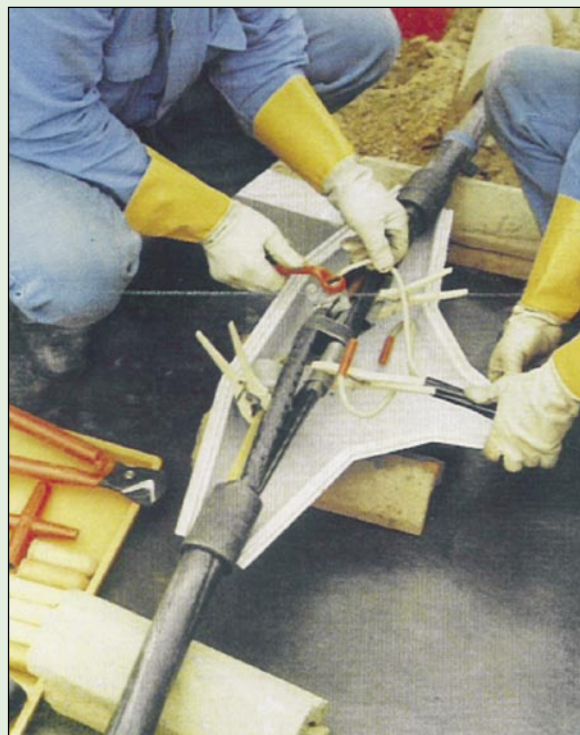
Rys. 5. Montaż mufy rozgałęznej wykonywany przez francuskich elektryków
