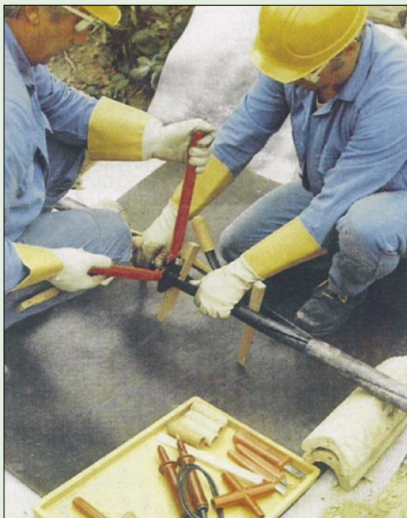
Rys. 5. Montaż mufy rozgałęznej wykonywany przez francuskich elektryków
