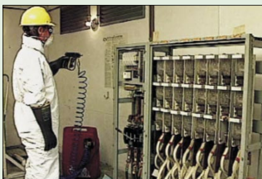
Rys. 9. Konserwacja izolacji metodą natryskową (źródło: referat węgierski 1.14 – G. Kovacs)
