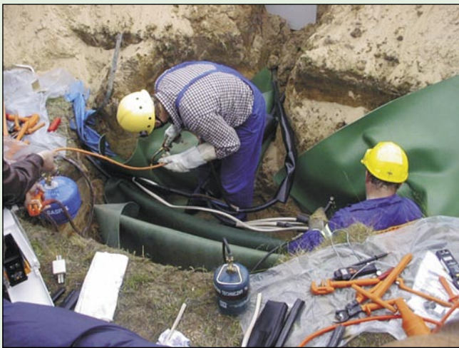
Rys. 3. Prace pod napięciem na liniach kablowych – pokaz podczas krajowej konferencji PPN w Krakowie (2004)
