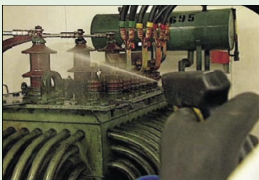
Rys. 9. Konserwacja izolacji metodą natryskową (źródło: referat węgierski 1.14 – G. Kovacs)
