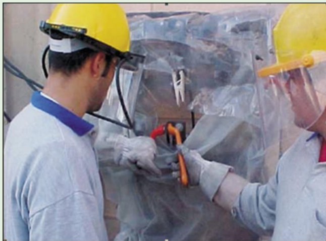
Rys. 1. Prace pod napięciem na miejskich urządzeniach rozdzielczych – pokazy: na Węgrzech (z lewej) oraz podczas krajowej konferencji PPN w Bielsku (2001)
