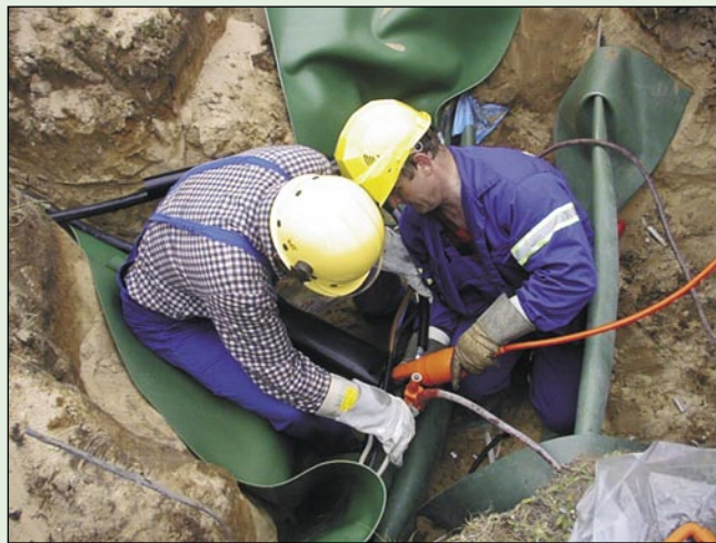
Rys. 3. Prace pod napięciem na liniach kablowych – pokaz podczas krajowej konferencji PPN w Krakowie (2004)
