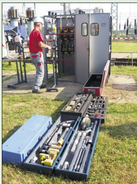
Rys. 11. Pokaz pracy pod napięciem na ICOLIM 2006 z zakresu czyszczenia urządzeń rozdzielczych
