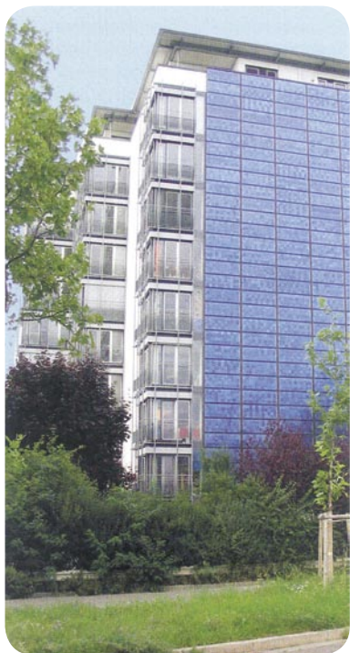
Rys. 3. Na południowej fasadzie starego budynku zainstalowano baterie fotowoltaiczne, zasilające mieszkańców w energię elektryczną
