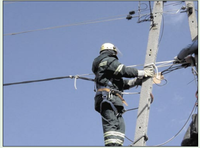
Węzeł prusik bywa stosowany do przejścia naciągu przewodu
