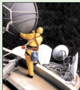
Rys. 3. Ochrona musi ograniczyć przestrzeń, w której jest wykonywana praca w sposób niedopuszczający pracownika do miejsca, w którym występuje zagrożenie upadkiem
