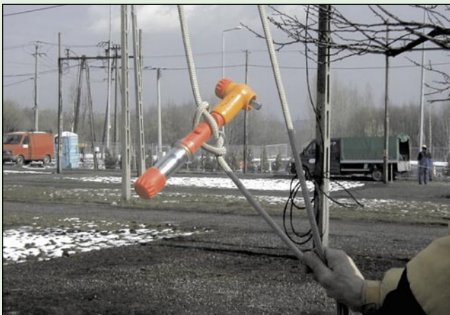
Węzeł rożkowy zastosowany do transportu narzędzia do miejsca pracy
