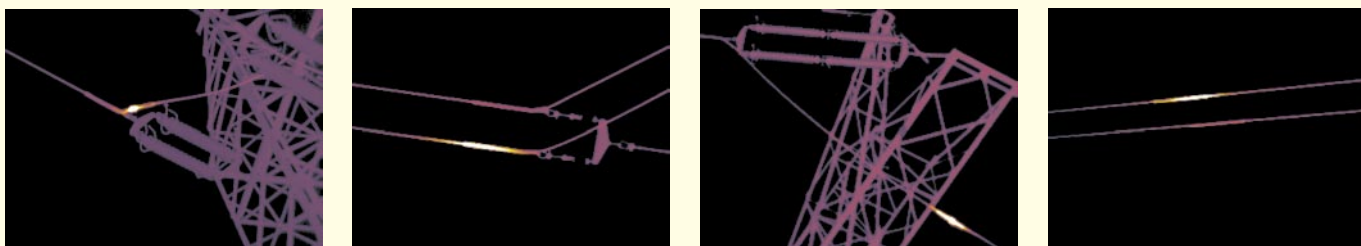
Rys. 2. Kontrola stanu połączeń prądowych linii 110 – 400 kV
