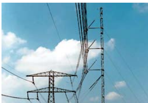
Rys. 7. Przykłady podłączeń linii tymczasowych z linią istniejącą [10, 22]
