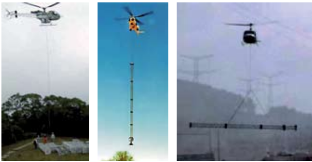
Rys. 6. Wykorzystanie śmigłowców do montażu konstrukcji gotowych słupów tymczasowej linii [8]
