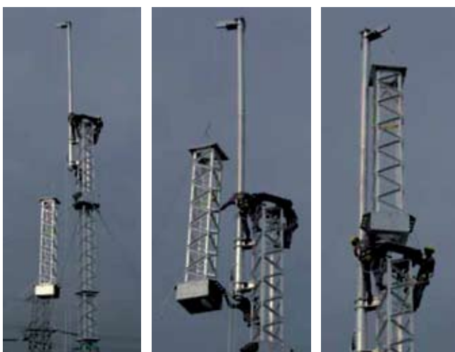
Rys. 3. Metody montażu konstrukcji słupów tymczasowej linii [8]
