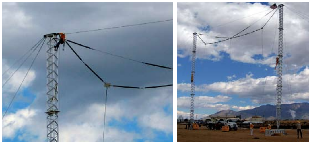
Rys. 2. Montaż słupa tymczasowego i jego osprzętu prezentowany podczas pokazu na konferencji ESMO'2006 (fot. B. Dudek) [11]
