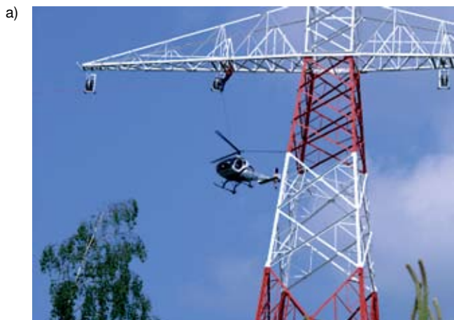
Rys. 7. Wykorzystanie śmigłowca do wciągania liny wstępnej i montażu przewodów na linii budowanej w terenie leśnym (fot. E. Piechoczek) [15]
