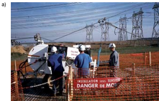
Rys. 4. Przykład ekwipotencjalnego stanowiska maszyn do wymiany przewodów a) brygady francuskiej ( www.rte-france.com ) b) amerykańskiej brygady przy pracy na linii 345 kV [13]
