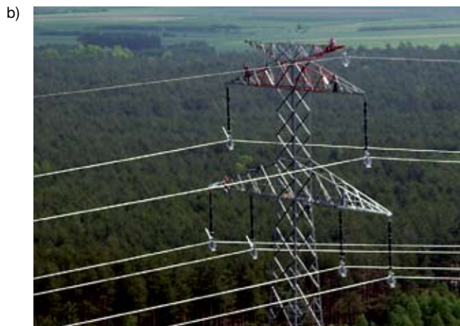
Rys. 7. Wykorzystanie śmigłowca do wciągania liny wstępnej i montażu przewodów na linii budowanej w terenie leśnym (fot. E. Piechoczek) [15]
