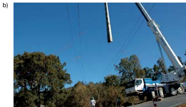
Rys. 12 Wbudowanie stupa w ciąg czynnej linii 60 kV [12] (z lewej – czerwoną linią zaznaczono zwis przewodów przed rekonstrukcją, zakreskowane pole to budowana droga)
