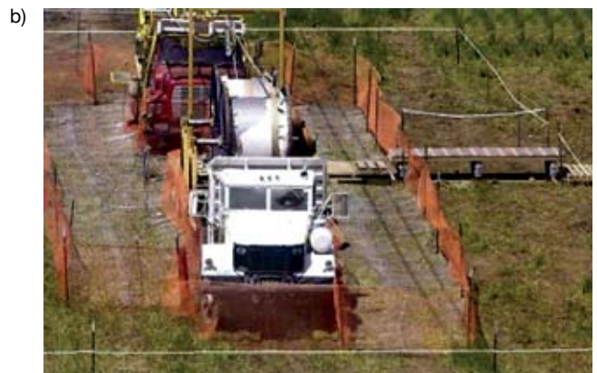
Rys. 4. Przykład ekwipotencjalnego stanowiska maszyn do wymiany przewodów a) brygady francuskiej ( www.rte-france.com ) b) amerykańskiej brygady przy pracy na linii 345 kV [13]
