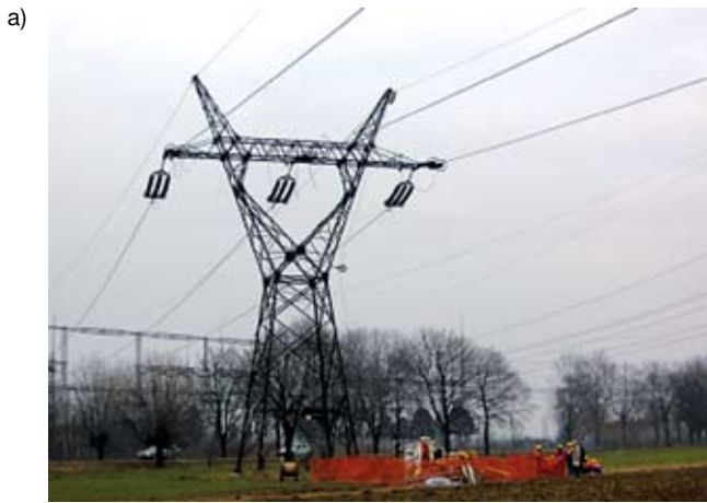
Rys. 3. Przykład ekwipotencjalnego stanowiska maszyn do wymiany przewodów brygady Eltel (fot. B. Dudek) a) ogólny widok stanowiska b) fragment z uziemiaczem przesuwającym i rolką kierunkową
