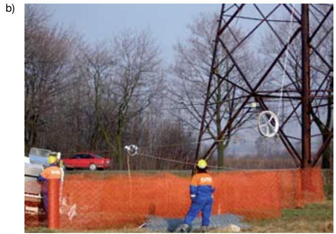
Rys. 3. Przykład ekwipotencjalnego stanowiska maszyn do wymiany przewodów brygady Eltel (fot. B. Dudek) a) ogólny widok stanowiska b) fragment z uziemiaczem przesuwającym i rolką kierunkową
