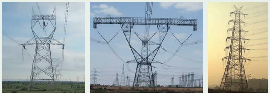
Rys. 5. Przykład typowych sylwetek słupów w Indiach, od lewej: linia 765 kV, 1200 kV oraz wielotorowa linia 400 kV [8]
