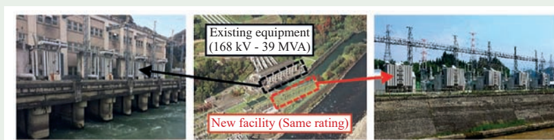
Rys. 21. Wymiana transformatorów olejowych na gazowe
