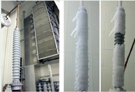
Rys. 2. Test oblodzeniowy izolatorów wsporczych
