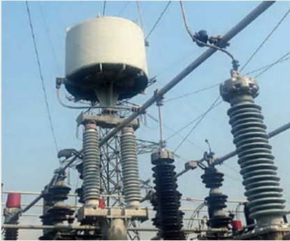
Rys. 16. Prowadzenie toru prądowego pomiędzy izolatorami wsporczymi
