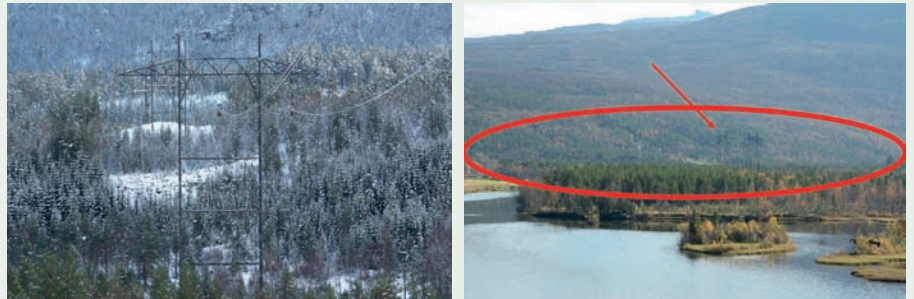
Rys. 2. Przykład norweskiej linii z zastosowaną technologią kamuflażu [12]
