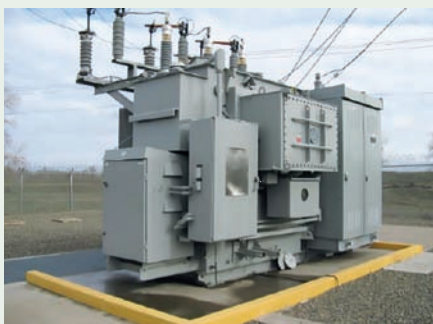
Rys. 5. Przykład transformatora mobilnego o zredukowanej wielkości
