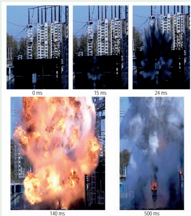
Rys. 18. Przekładnik prądowy 245 kV w izolacji olejowej przy zwarceniu wewnętrznym asymetrycznym 50 kA rms przy czasie jego trwania 200 ms
