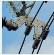
Rys. 28. Zaprojektowane zawieszenie przelotowe do linii kompaktowej 380 kV
