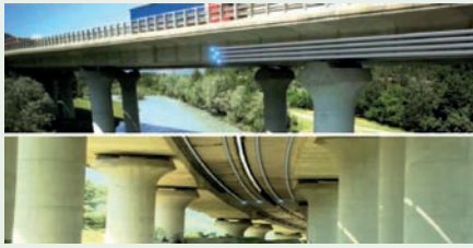
Rys. 9. Kable HVDC 320 kV na infrastrukturze autostrady [B1-124]
