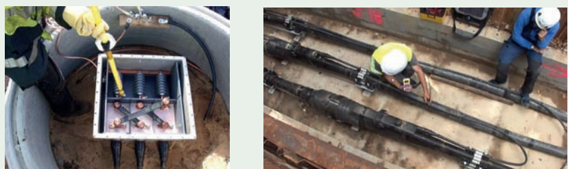
Rys. 7. Skrzynka cross-bondingowa umieszczona w betonowym kręgu oraz sprawdzanie poprawności połączeń żył powrotnych przy pomocy małego urządzenia przenośnego [B1-115]
