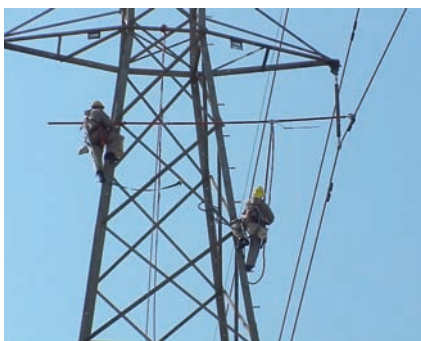
Rys. 6. Zastosowanie przenośnych iskierników ochronnych PPAG wg [8]
