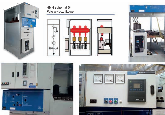
Rys. 5. Przykładowe pole rozdzielnic typu HMH
