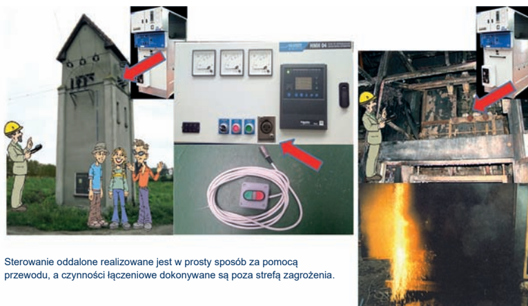
Rys. 7. Oddalone sterowanie czynnościami łączeniowymi w rozdzielnicach HMM
