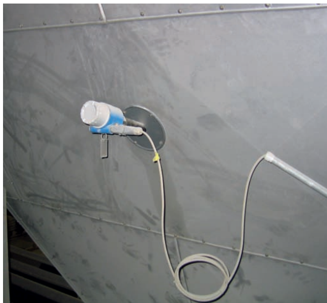
Czujnik pojemnościowy Solicap S do sygnalizacji poziomu pyłu w leju elektrofiltra
