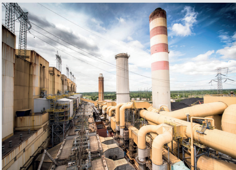
Rys. 6. Widok na elektrofiltry i Instalację Odsiarczania Spalin
