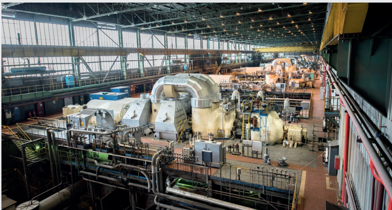
Rys. 5. Maszynownia – widok na turbiny i generatory
