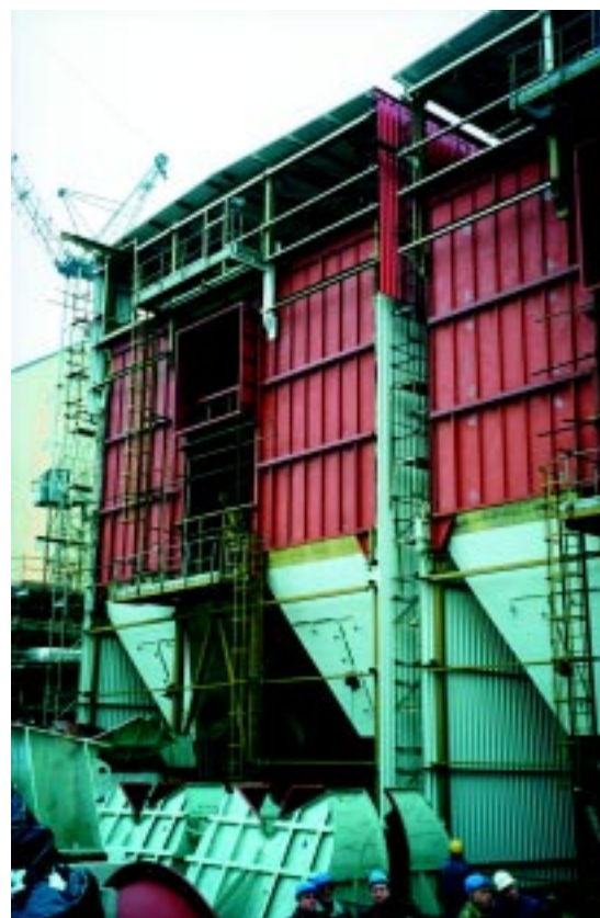
Montaż elektrofiltrow w Elektrowni Siersza SA
