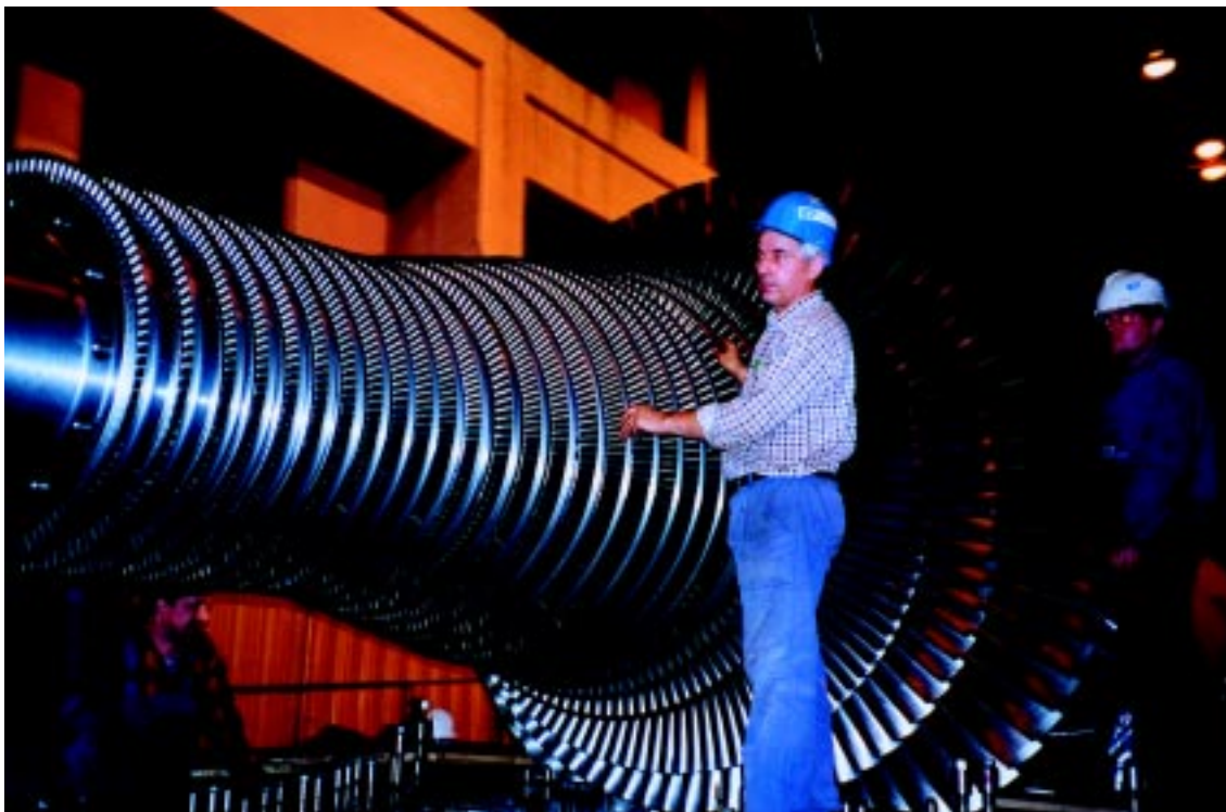
Montaż wirnika turbiny 70 MW w Elektrowni Jaworzno II (obecnie Elektrownia Jaworzno III)
