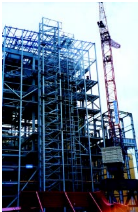
Montaż konstrukcji kotła fluidalnego BCF-100 w EC Katowice SA
