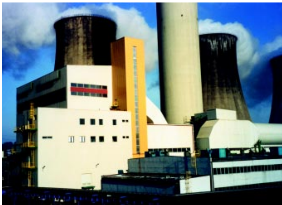
Instalacja Odsiarczania Spalin w Elektrowni Łaziska SA
