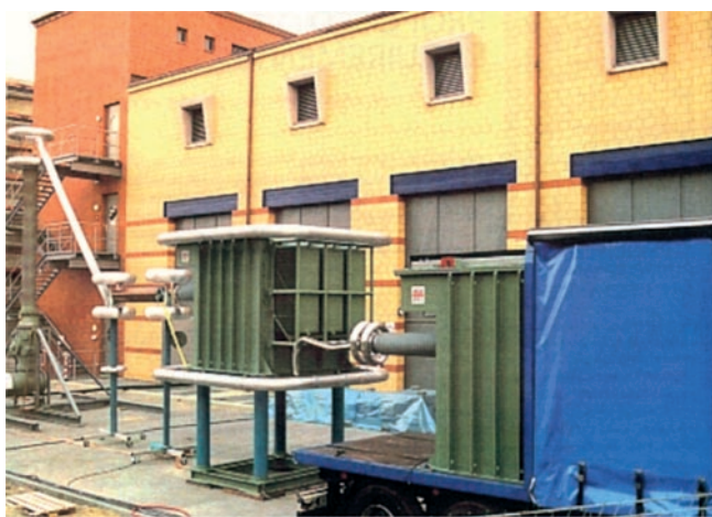
Rys. 6. Badanie linii kablowej 400 kV po ułożeniu w Berlinie – rezonansowy system probierczy
