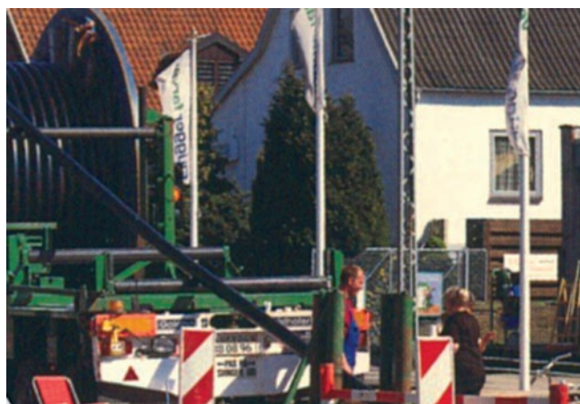
Rys. 7. Widok kabla z linii Metropolitan oraz bęben kablowy ustawiony na ulicy Kopenhagi
