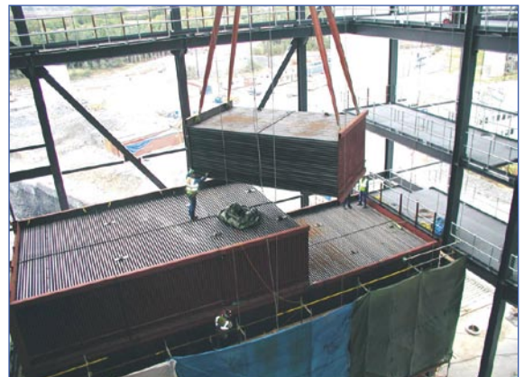
Rys. 4. Montaż pakietu podgrzewacza powietrza
