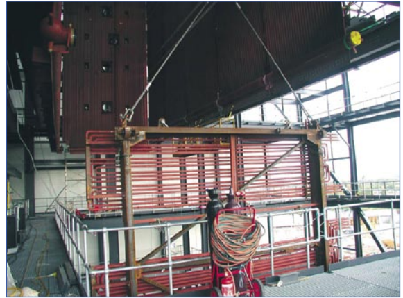
Rys. 3. Montaż węzownic przegrzewacza pary
