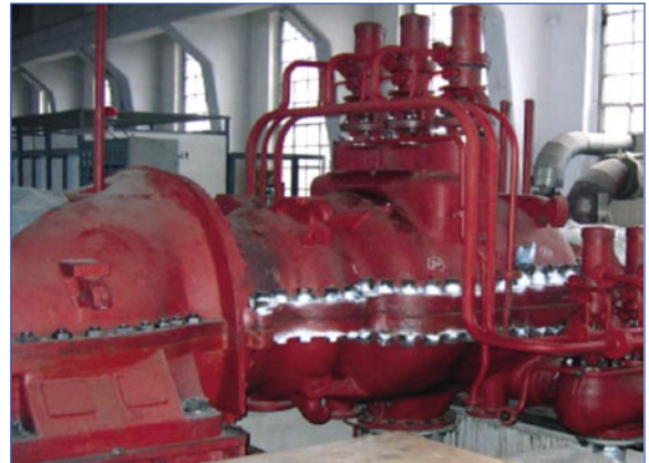
Rys. 7. Turbozespół upustowo-kondensacyjny o mocy 5 MW w trakcie montażu
