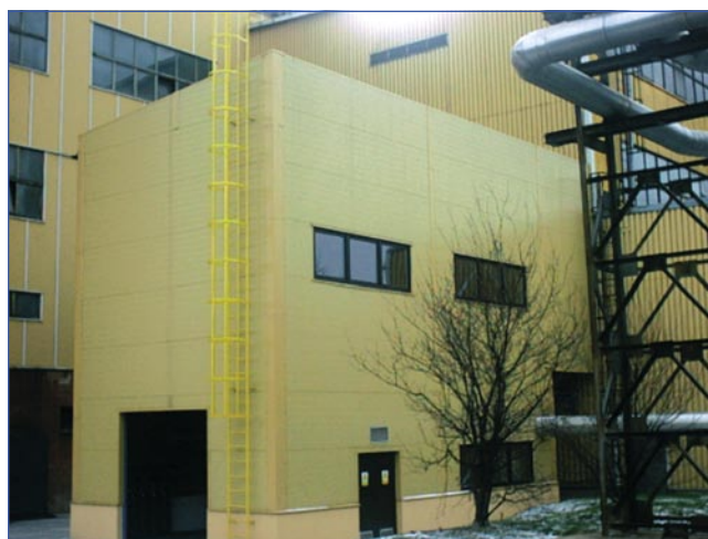
Rys. 5. Nowy budynek maszynowni dla turbozespołu 1,5 MW
