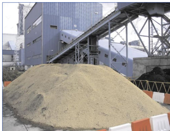
Rys. 5. Operacyjne składowisko biomasy z ciągiem nawęglania
