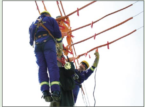
Rys. 20. Użycie bocznika izolowanego podczas prac pod napięciem
