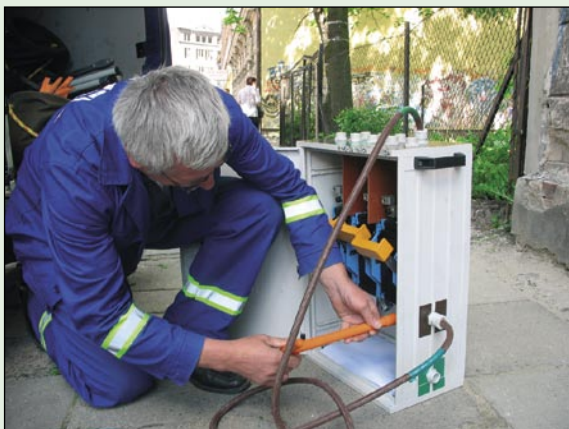
Rys. 21. Przygotowanie bocznika do użycia
