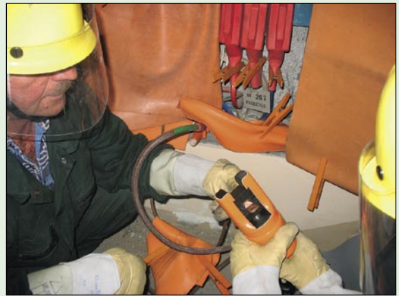
Rys. 24. Zaprasowywanie nowej końcówki kabla (zasilanie utrzymane poprzez bocznik)
