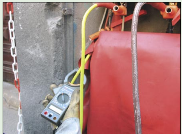
Rys. 23. Sprawdzenie przebiegu obciążenia przez bocznik
