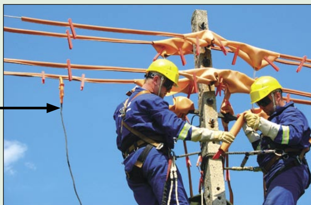
Rys. 18. Przenośny rozłącznik bocznikujący jedno i trójfazowy na prądy 200–350A
