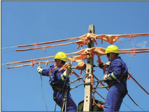
Rys. 20. Użycie bocznika izolowanego podczas prac pod napięciem
