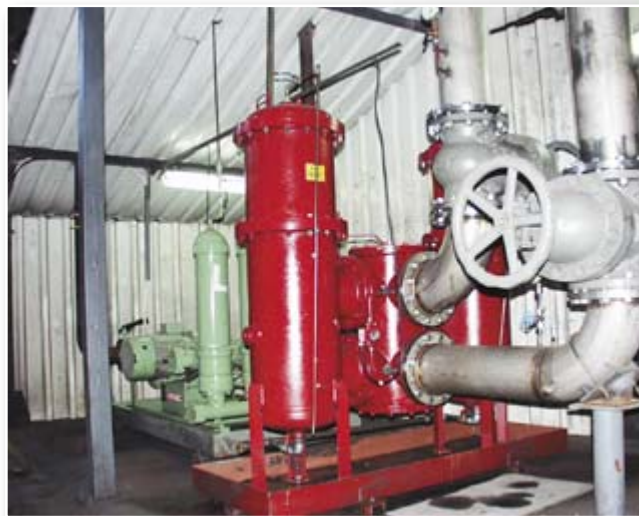
Rys. 2. Filtr sieciowy oleju smarowego bloku 225 MW
