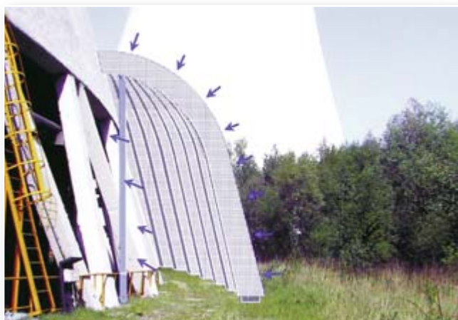
Rys. 2. Projektowany tłumik szczelinowy na wlocie do chłodni
