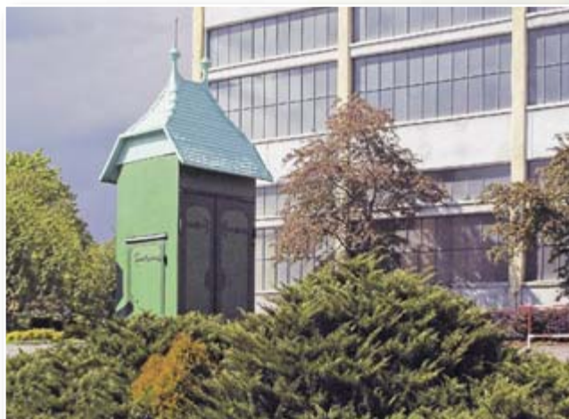
Zabytkowa stacja transformatorowa z Bytomia przed budynkiem muzeum
