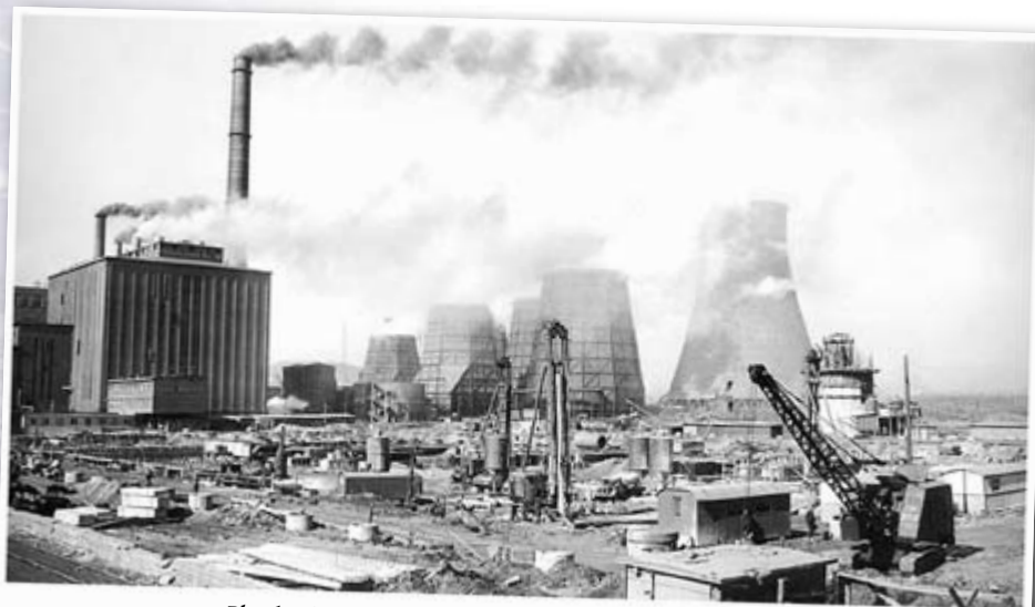
Plac budowy tuż przy pracującej starej części elektrowni
