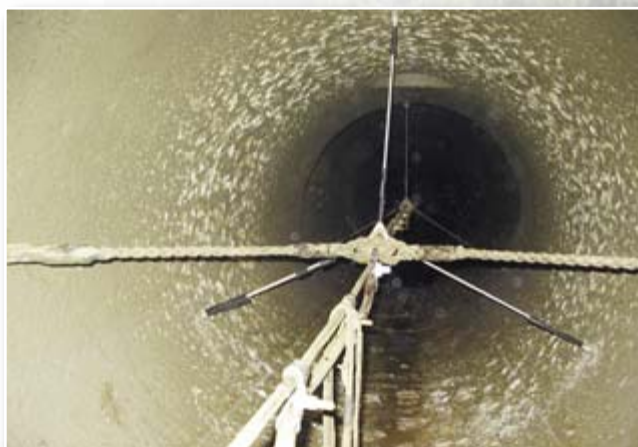
Rys. 2. Fragment zawiesia ochrony katodowej
