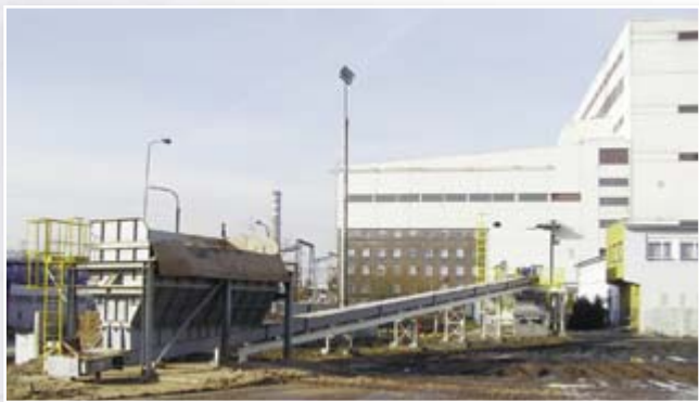
Uproszczona instalacja podawania biomasy
