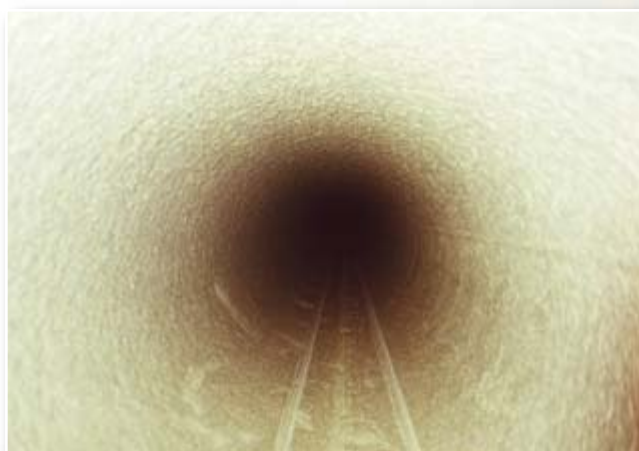
Rys. 4. Rurociąg po cementacji
