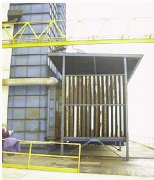
Rys. 3. Czerpnia powietrza zewnętrznego bloku nr 9 przed modernizacją
