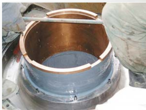
Rys. 4. Osadzenie tulei na kompozycie Belzona®(1321). Obciążalność węzła wzrosła siedmiokrotnie
