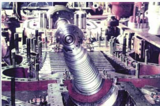
Rys. 1. Układ przepływowy turbiny TK-125 w trakcie montażu
