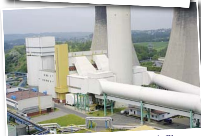
Instalacja odsiarczania spalin bloków 225 MW
