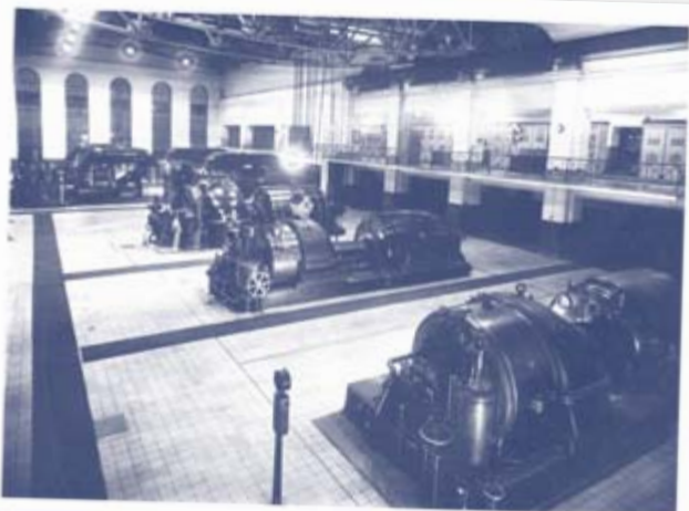
Hala maszyn z turbozespołami 1 – 5
