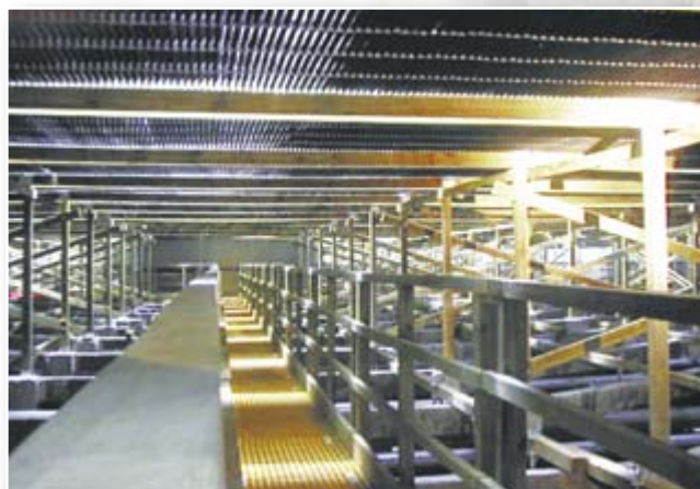
Rys. 4. Zmodernizowany wodorozdział i eliminator unosu kropel chłodni kominowej nr 12
