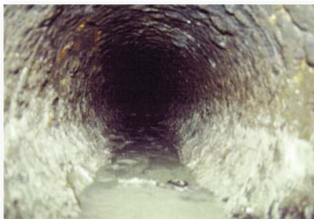
Rys. 3. Rurociąg przed cementacją
