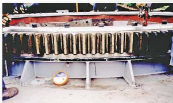
Rys. 3. Osadzenie łożyska obrotu zwalowarko-ładowarki na kompozycie Belzona®(1111). Wydział nawęglania
