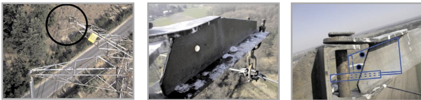
Rys. 5. Montaż blokady zawieszenia przewodu odgromowego na czynnej linii
