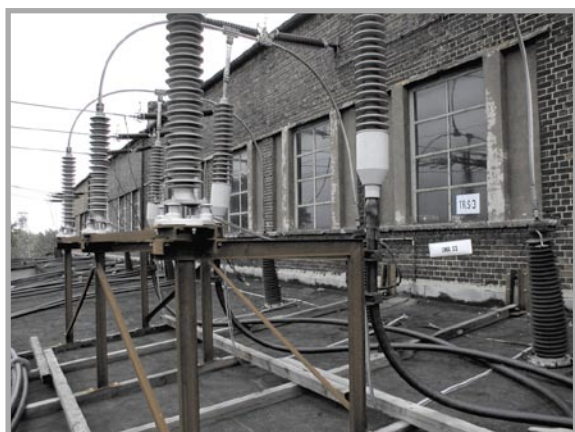
Rys. 8. Zastosowanie przenośnej linii kablowej 110 kV
