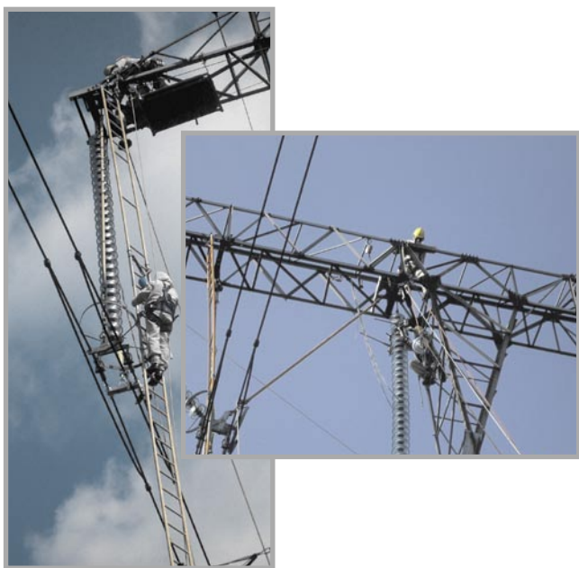
Rys. 2. Prace pod napięciem przy wymianie izolatorów na linii 400 kV podczas szkolenia
