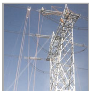
ICOLIM 1996: Wymiana odciągowego łańcucha izolatorów z użyciem drabiny samozatraskowej
