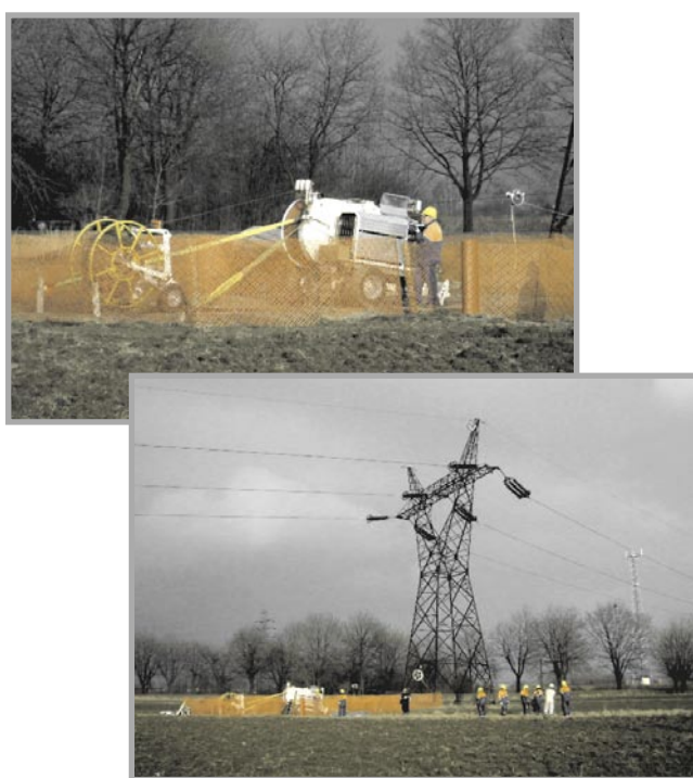
Rys. 7. Przygotowanie do wymiany przewodu odgromowego na OPGW (ćwiczenia pod Tarnowem)
