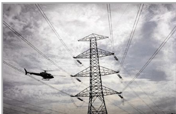
ICOLIM 1998: Mycie izolacji linii pod napięciem
