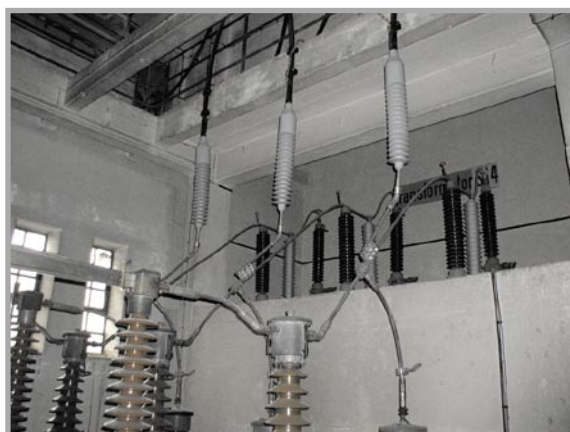
Rys. 8. Zastosowanie przenośnej linii kablowej 110 kV
