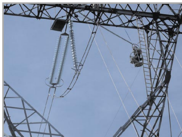
Rys. 4. Pokaz przygotowany na ICOLIM 2008 – wymiana łańcucha izolatorów przy użyciu kabiny podwieszanej do izolatora kompozytowego
