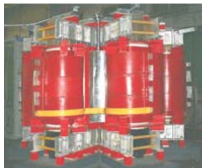
Rys. 2. Nadprzewodzący ogranicznik prądu zwarciovego 35 kV, 90 MVA [1]
