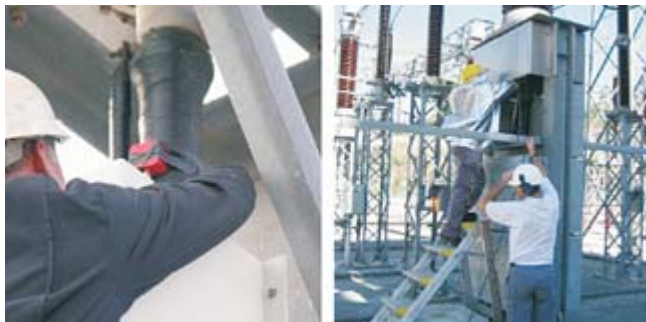
Rys. 3. Montaż sensorów na głowicy: po lewej 132 kV, po prawej 220 kV [10]
