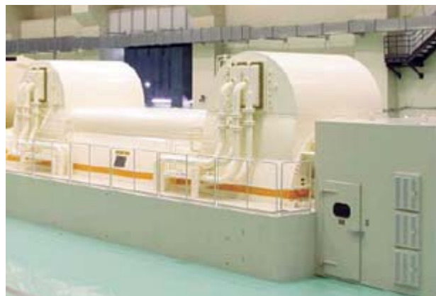
Rys. 2. Turbogenerator 60 Hz o mocy 1570 MVA firmy Hitachi
