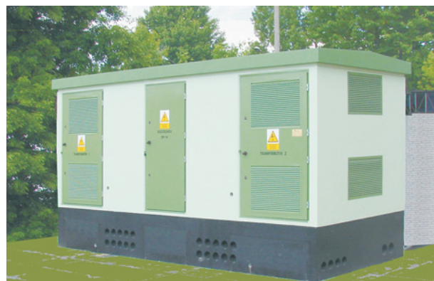
Rys. 1. Stacja transformatorowa STLmb-6 z widocznym fundamentem
