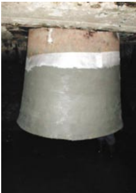
Rys. 5. Rura ssawna w trakcie renowacji
