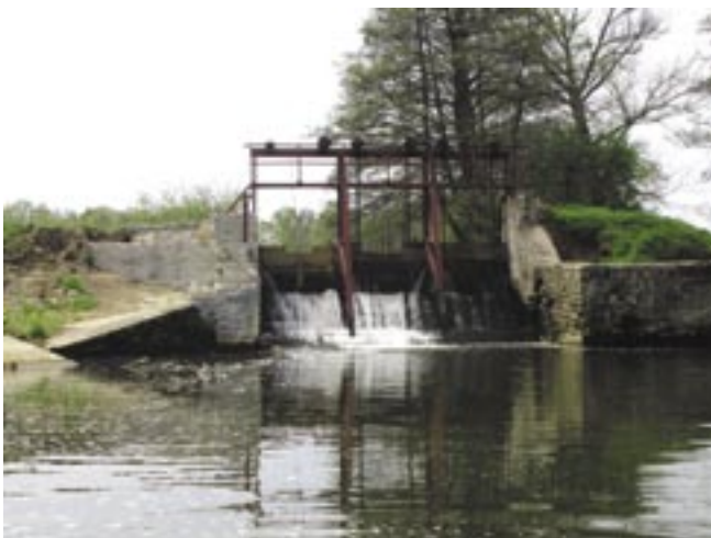
Rys. 2. Jaz zastawkowy po renowacji (widok od strony wody dolnej)
