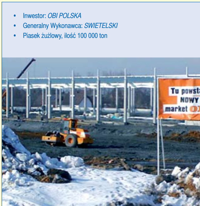
Rys. 3. Piasek żużlowy. Wykonanie nasypu pod obiekt handlowy w Rybniku
