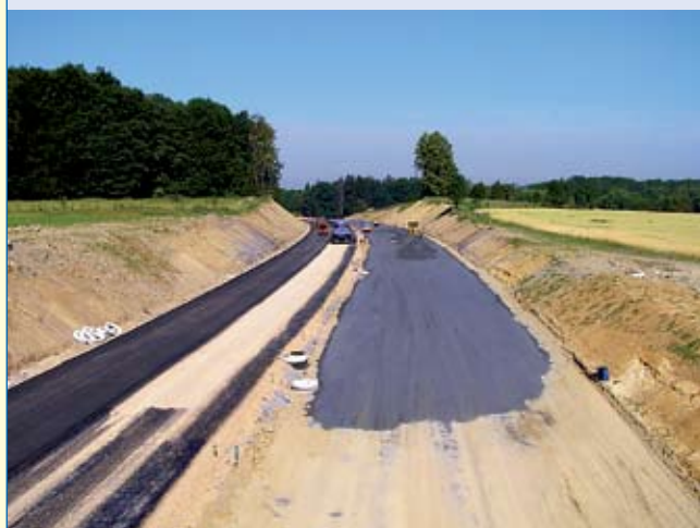
Rys 1. Mieszanka betonowo-żużłowa BP 2,5. Droga Ekspresowa Gieszyn – Bielsko
