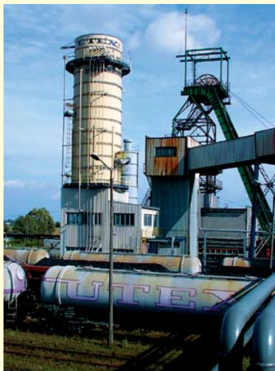
Rys. 1. Instalacja do wytwarzania mieszanin podsadzkowych na bazie UPS w KWK Borynia
