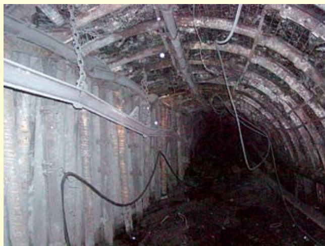
Rys. 5. Ochronny pas podporowy ze spoiwa mineralnego UTEX-15 w KWK Rydułtowy-Anna
