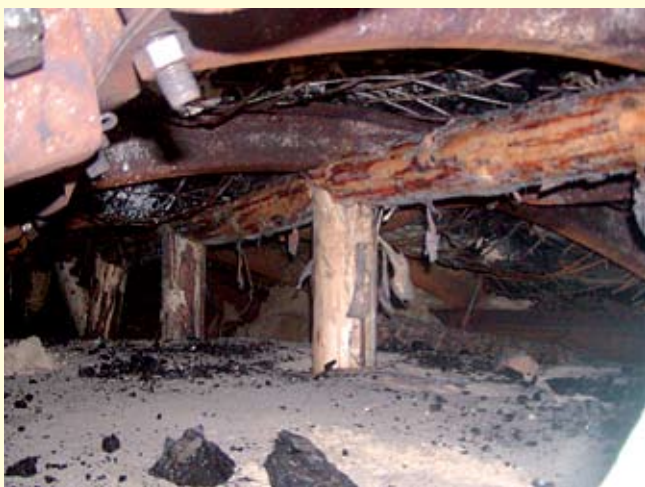
Rys. 3. Poadszanie wyrobiska korytarzowego przyścianowego mieszaniną podsadzkową na bazie UPS (ZG Piekary)
