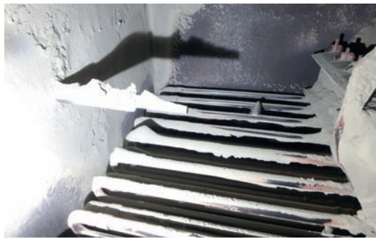
Rys. 6. Zniszczone uszczelnienia klap by-passowych wykryte w czasie inspekcji
