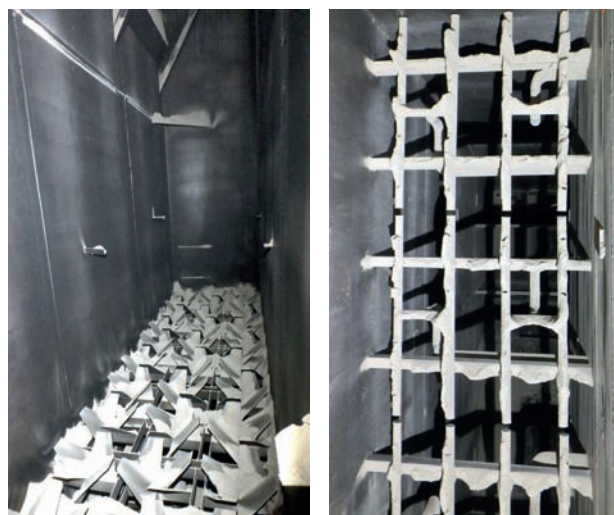
Rys. 5. Akumulacja popiołu na mikserze statycznym oraz dyszach wtrysku reagenta
