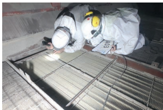
Rys. 8. Pracownicy ENERGOPOMIARU w czasie inspekcji. Szczegółowe oględziny pakietów katalitycznych
