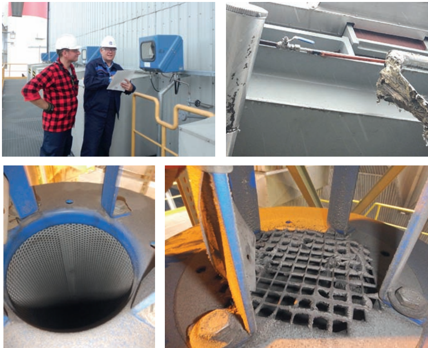
Rys. 1. Inspekcja instalacji SCR w czasie pracy
